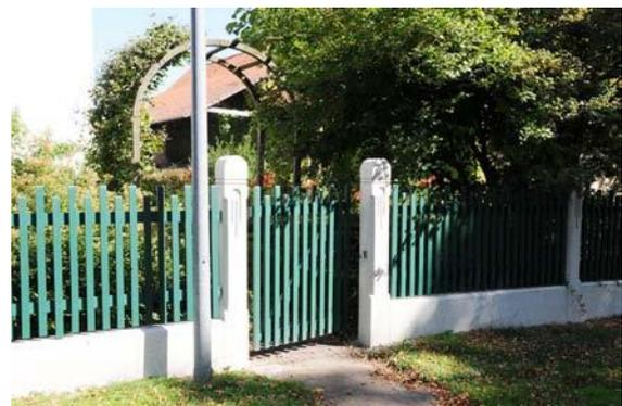
Abb. 182: Staketzaun mit Betonpfeilern
